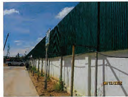
ภาพที่ 2-2 การล้อมรั้วชั่วคราวรอบพื้นที่ก่อสร้าง
