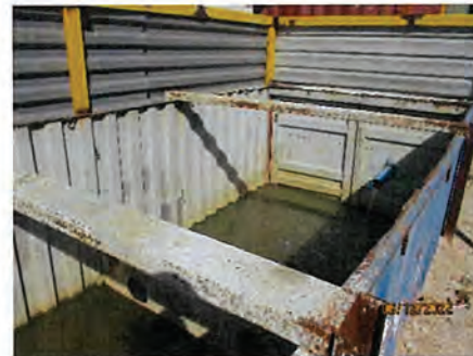
ภาพที่ 2-11 รางระบายน้ำชั่วคราวและบ่อตกตะกอน
