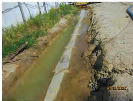
ภาพที่ 2-11 รางระบายน้ำชั่วคราวและบ่อตกตะกอน
