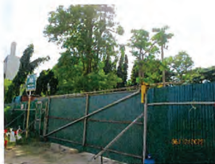
ภาพที่ 2-2 การล้อมรั้วชั่วคราวรอบพื้นที่ก่อสร้าง
